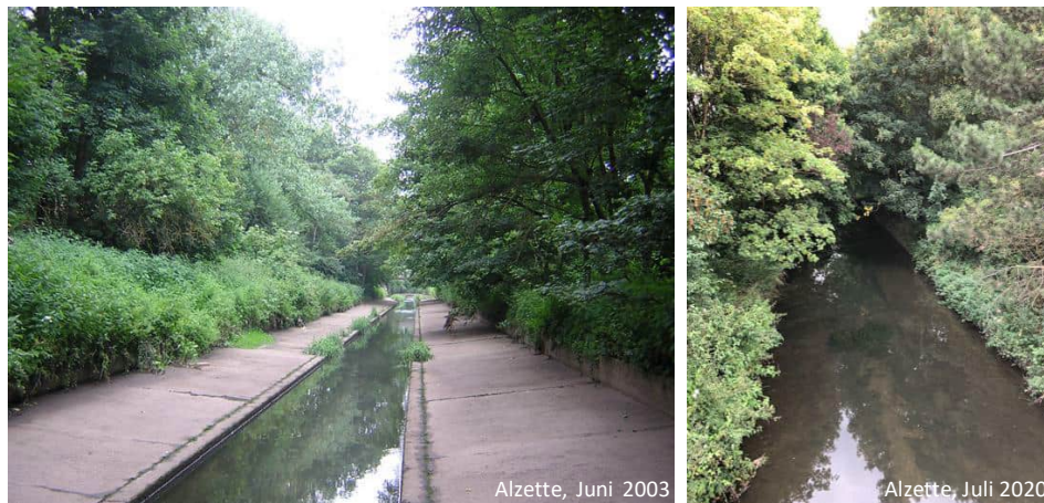
Abbildung 7: Betoniertes Bachbett (links) VS renaturiertes Bachbett (rechts) am südlichen Rand vom Pudel
