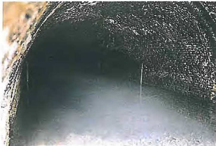
Photo 63 : Entrée du souterrain de Bernistap, voûte en briques. Buret, (B). ( www.users.swing.be/depierpont.q/cmm.index.html )
