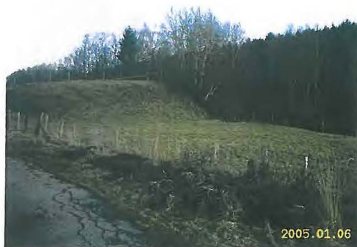
Photo 64 : Remblai haut de cinq mètres, longeant la tranchée d'accès au chantier. Hoffelt, L. www.users.swing.be/depierpont.q/cmm.index.html
