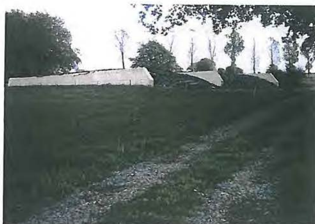
Photo 14 : Installation d'ensilage de la parcelle 1524 (photo prise le 07/10/04).
